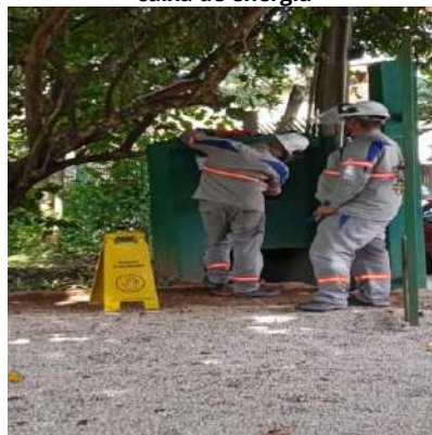
Figura 178: ENEL troca e manutenção da caixa de energia
