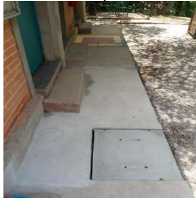
Figura 142: aplicação de piso drenante lateral a bocha - depois
