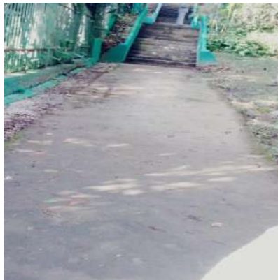
Figura 122: limpeza externa da praça anexa - antes
