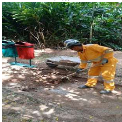
Figura 153: escavação para recuperação de paralelepípedos na trilha do lago - antes
