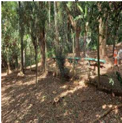
Figura 151: remoção de gradil entre a composteira e o lago - antes
