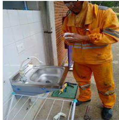
Figura 134: instalação de tanquinho externo a copa
