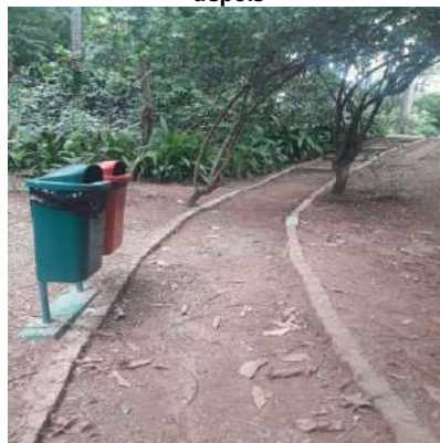
Figura 154: escavação para recuperação de paralelepípedos na trilha do lago - depois
