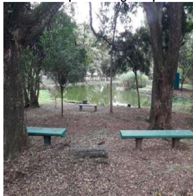
Figura 152: remoção de gradil entre churrasqueiras e lago - depois
