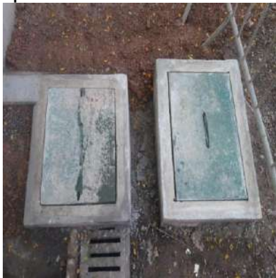
Figura 143: adequação das bordas e pintura das caixas hidráulicas - antes
