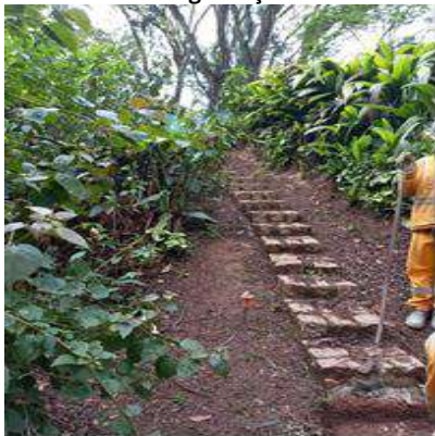
Figura 137: remoção de escada em desconformidade com as normas de segurança
