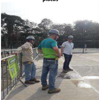
Figura 129: Manutenção do piso das quadras com selante e lixamento das placas
